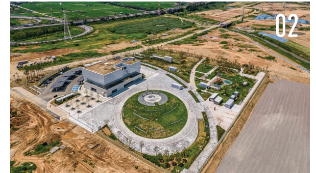
02 고덕공공하수처리시설 위치 : 경기도 평택시 고덕면 궁리 289-10번지 사업내용 : 용량 Q=128,000m 3 /일, 완전지하화, 공법 A2O+MBR
